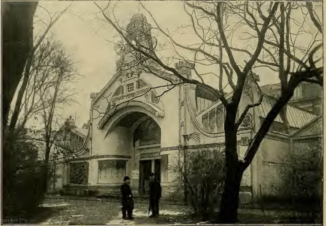
FAÇADE DU PAVILLON DU PETIT OUTILLAGE.
